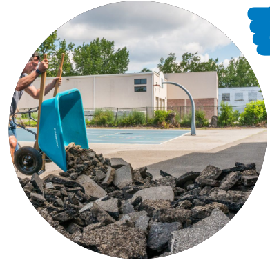
Enlever du béton pour verdir
