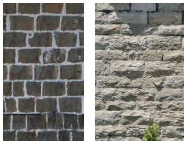
Maçonnerie de pierres
