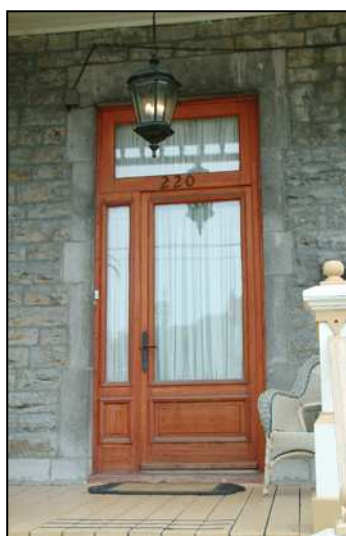
Porte munie d'une baie latérale et d'une imposte vitrées.
