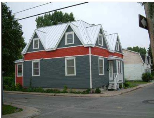
Les couleurs permettent de rehausser les qualités architecturales d'une demeure.
