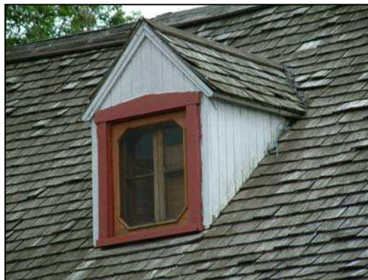
Toiture en bardeaux de cèdre.
