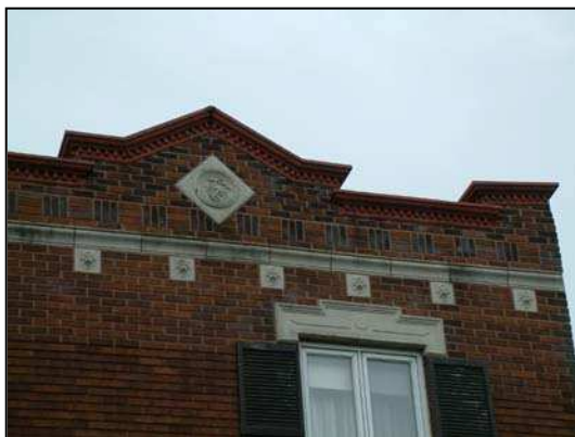
Parapet en brique décoré d'une corniche moulurée.
