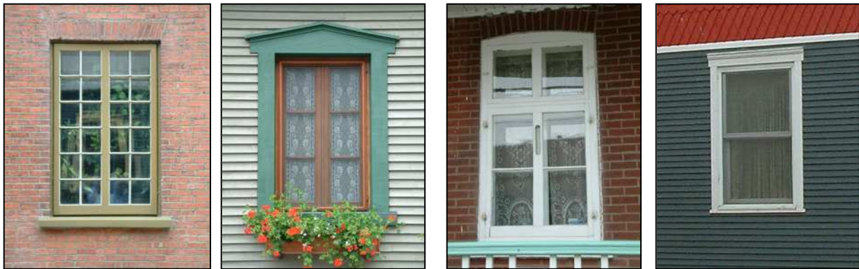
Fenêtre à battants à petits carreaux.
