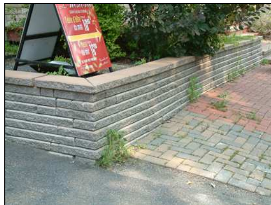
Les blocs de maçonnerie préfabriqués conviennent moins bien aux secteurs patrimoniaux. Ici, une pierre naturelle aurait été préférable pour la confection des murets.
