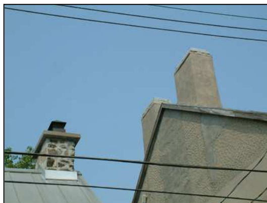
Cheminées en maçonnerie.
