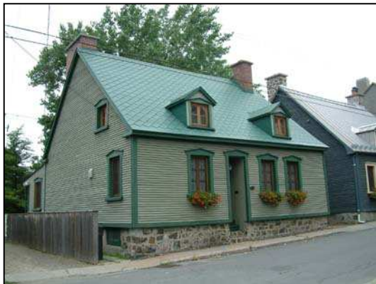
Toiture en tôle à la canadienne.
