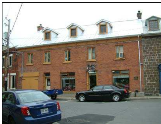
Bâtiment du XIX e siècle revêtu de briques.
