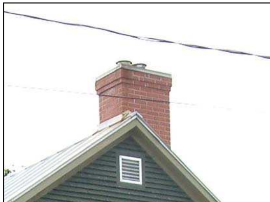
Cheminée en brique.
