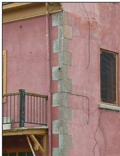
Chaînage d'angle en pierre.
