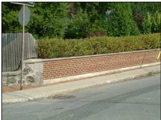
Muret en maçonnerie combiné à une haie de végétaux.
