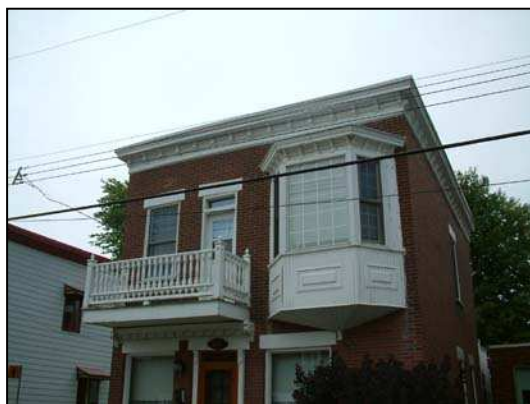
Le balcon et l'oriel de cet immeuble, décorés de boiseries ornementales, donnent du relief au volume.
