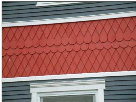
Mur revêtu de bardeaux de bois peints. Le découpage des bardeaux peut créer des motifs décoratifs.
