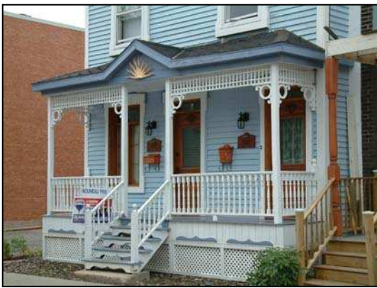
Galerie comportant plusieurs éléments d'ornementation dont une balustrade ouvragée, des aisseliers et une frise décorative.
