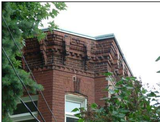
Corniche en brique au sommet d'un édifice de l'arrondissement historique.
