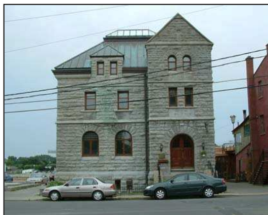
Ancien bureau de poste revêtu d'un parement de pierre.
