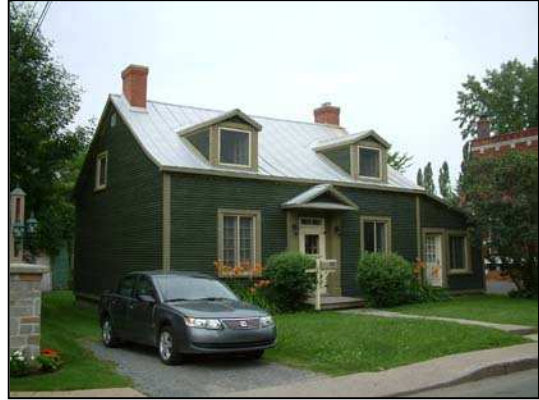
Agrandissement latéral du volume principal par une annexe au toit en appentis.
