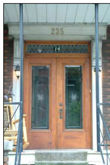
Porte à double vantail surmontée d'une imposte vitrée.
