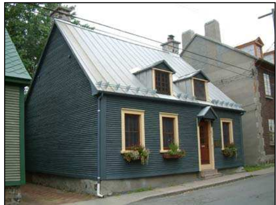
Toiture en tôle pincée.
