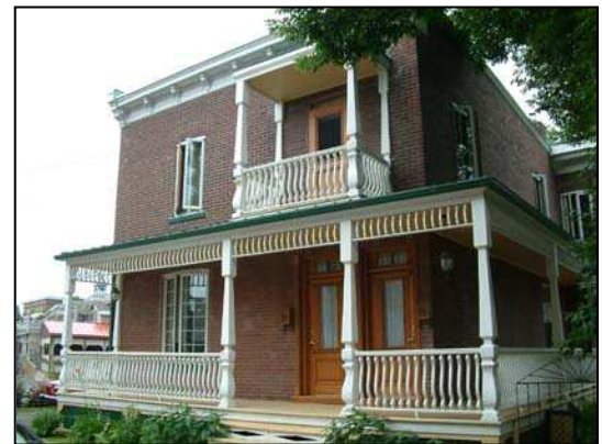
Galerie et balcon avec colonnes ouvragées, balustres découpés et frise décorative.
