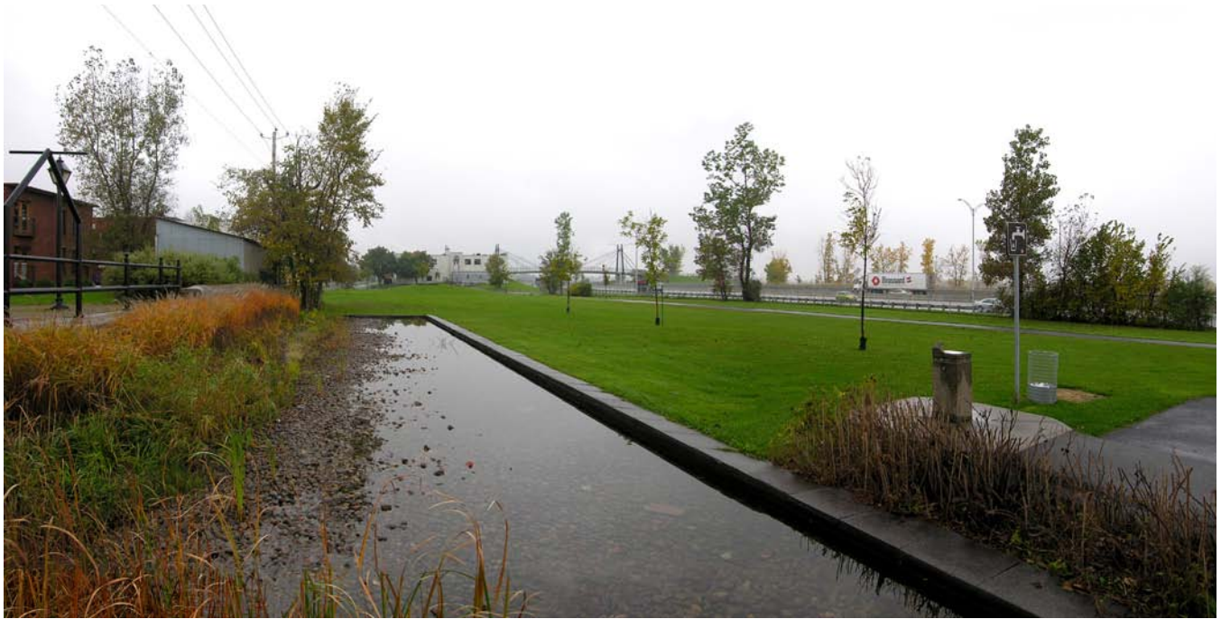
Fig. 17 : Photo du secteur de la digue vers le sud |
