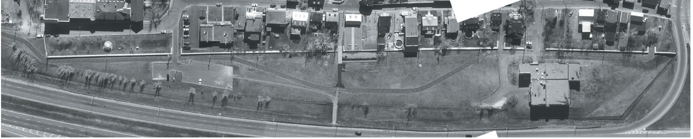
Fig. 14 : Photo aérienne du secteur de la digue |
