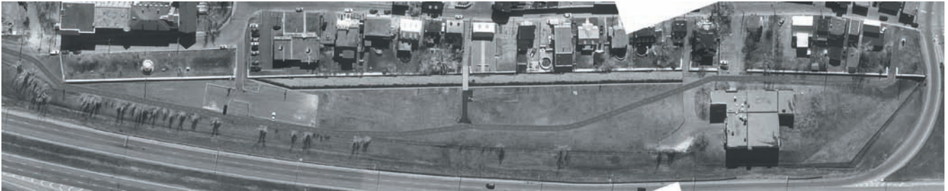
Fig. 15 : Photo aérienne du secteur de la digue avec la proposition de bassin |
