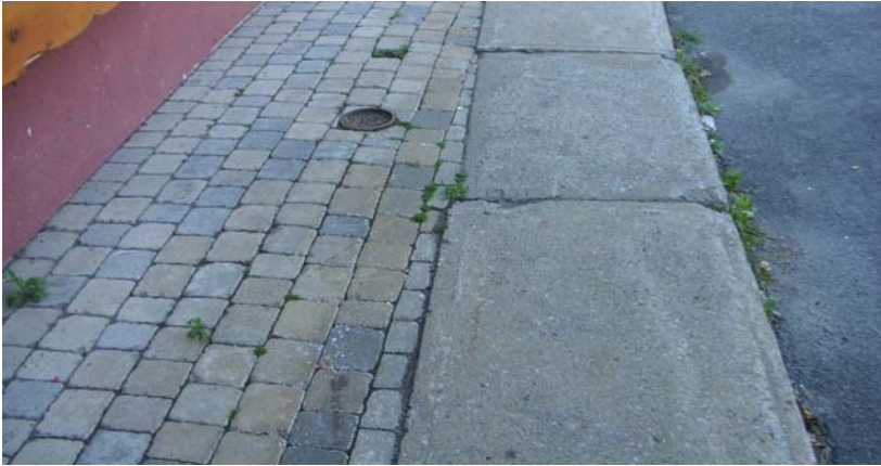
Fig. 8 : Exemple d'aménagement d'espace résiduel |
