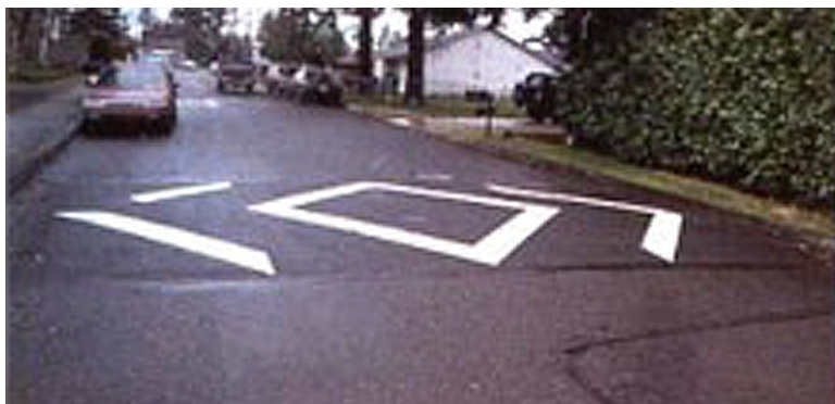
Fig. 30 : Exemple de dos d'âne allongé |
