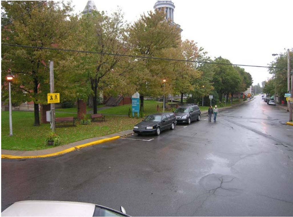
Fig. 57 : Photo du secteur à partir de l'intersection du chemin Saint-Jean et de la rue Sainte-Marie |
